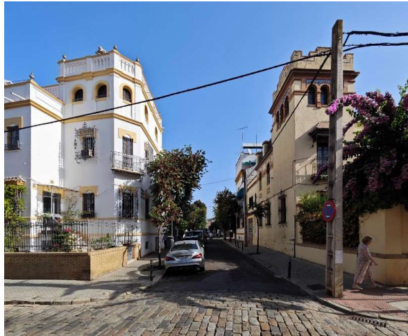
Calle Porvenir 17 y 19
